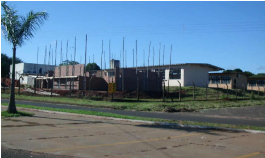
Figura 4. CPTREN tomando forma do andar térreo e iniciando o andar superior.
