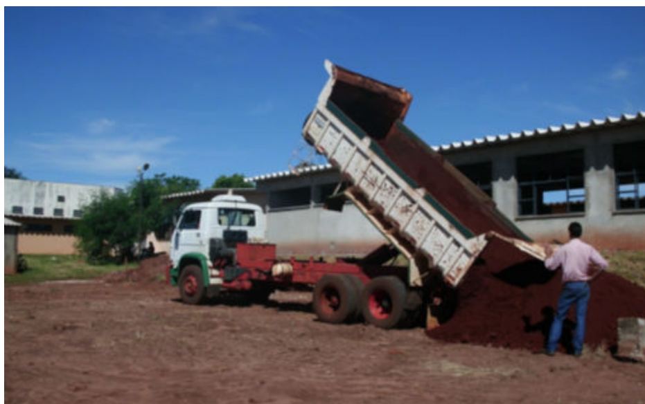
Figura 1. Caminhões descarregando terra para o início da construção do novo laboratório de pesquisa na UEMS unidade de Naviraí.
