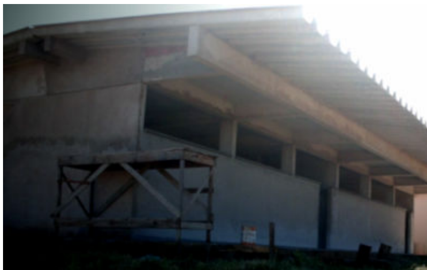
Figura 2. Laboratório de processamento de frutas e sala de aula em fase final de construção.
