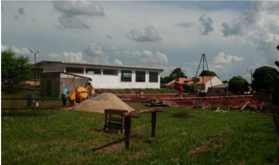
Figura 3. Iniciada a perfuração para a construção do CPTREN na UEMS de Naviraí.
