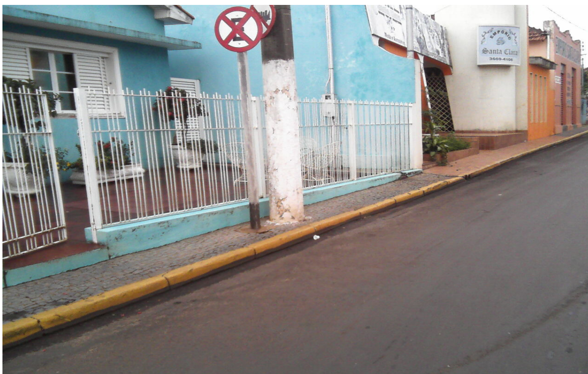
Fotografia 3 – Calçada com placa de sinalização e poste no percurso.
