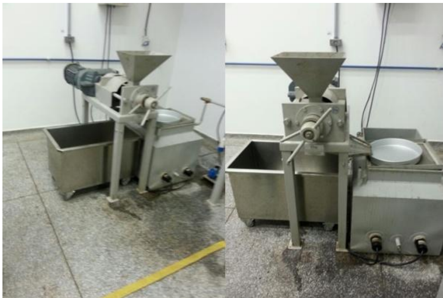
Figura 1. Sistema de prensa hidráulica utilizada para a extração do óleo de Pinhão Manso.
