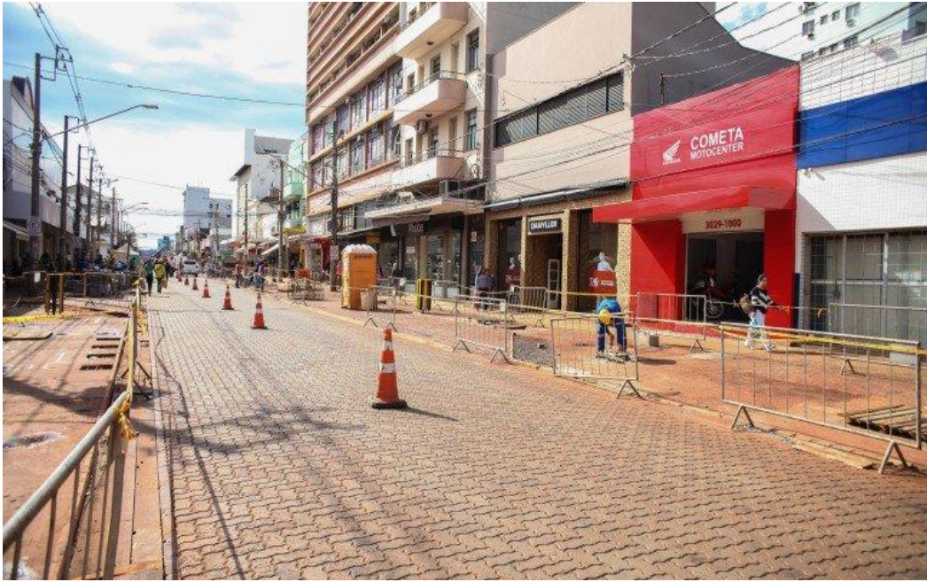
Figura 3 – Rua 14 de Julho – transformada em 2019.
